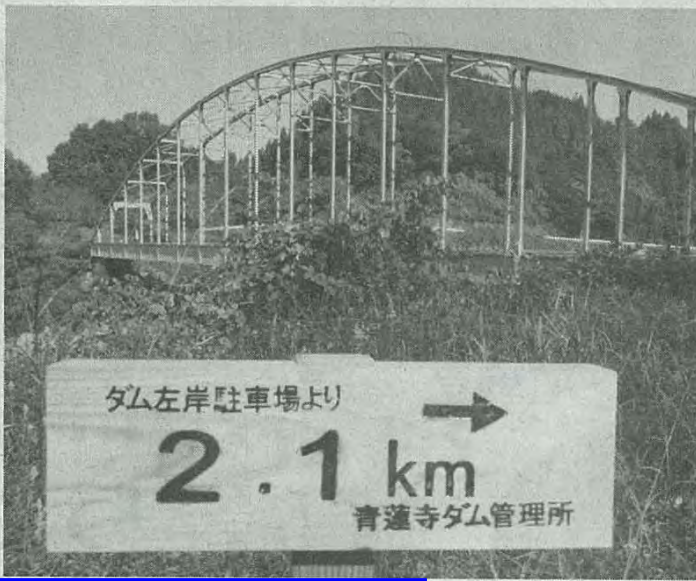
青蓮寺ダム管理事務所が設置したキロポスト標識 名張市青蓮寺で
