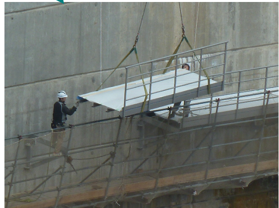
歩廊設置状況
