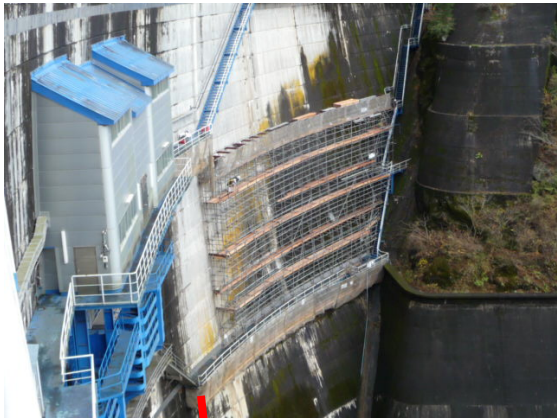
足場工設置状況（左岸）
