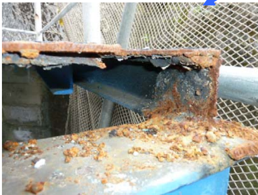
歩廊撤去（歩廊腐食状況）
